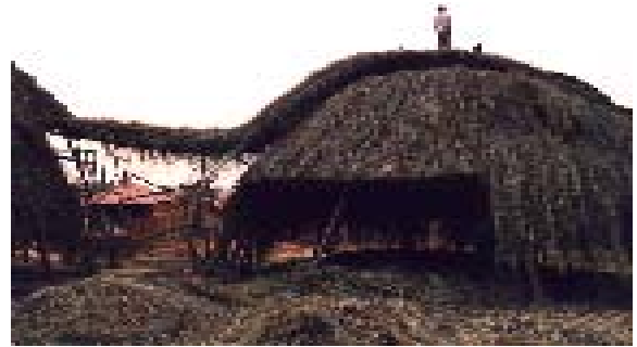
FIGURA 42 COLOCAÇÃO E CORTE DAS FOLHAS DE BACURÍ FOTO: ARQ. RUBENS CARDOSO JR.
