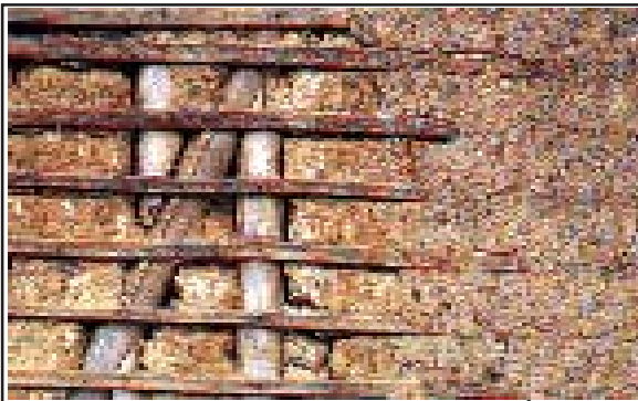
FIGURA 22 - DETALHE DE PAREDE COM PAINÉIS DE TIRA DE BAMBU, REBOCADA COM BARRO. FONTE: ARQ. RUBENS CARDOSO JR. (ÍNDIA)
