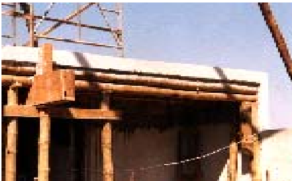
FIGURA 39 VIGAS DE SUSTENTAÇÃO DA LAJE. FOTO: ARQ. RUBENS CARDOSO JR.
