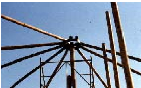
FIGURA 35 ANEL METÁLICO, JÁ COM A FIXAÇÃO DAS VARAS DE BAMBU (ESTRUTURA) FOTO: ARQ. RUBENS CARDOSO JR.
