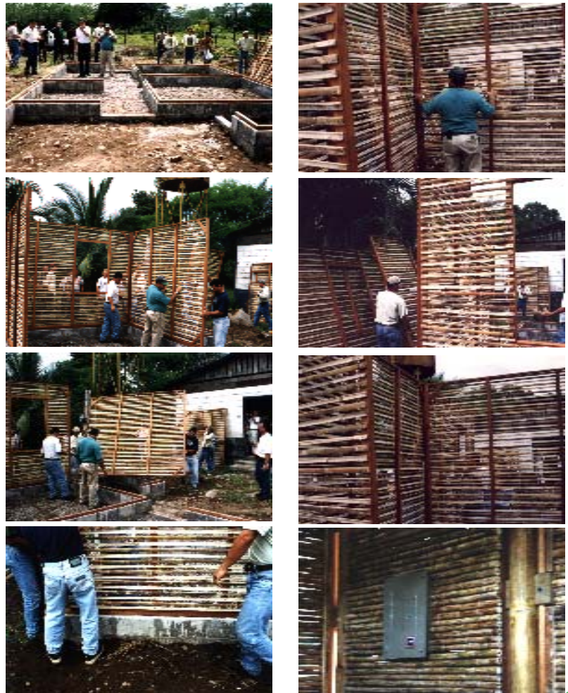
FIGURA 20 - SEQUÊNCIA DE MONTAGEM DE UMA CASA COM PAINÉIS DE CANA BRAVA - (45 MINUTOS). FONTE: ARQ. RUBENS CARDOSO JR. (FUNBAMBU - COSTA RICA).
