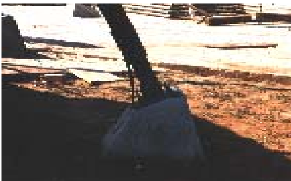
FIGURA 28 SAPATA, EM CONCRETO APARENTE. FOTO: ARQ. RUBENS CARDOSO JR.
