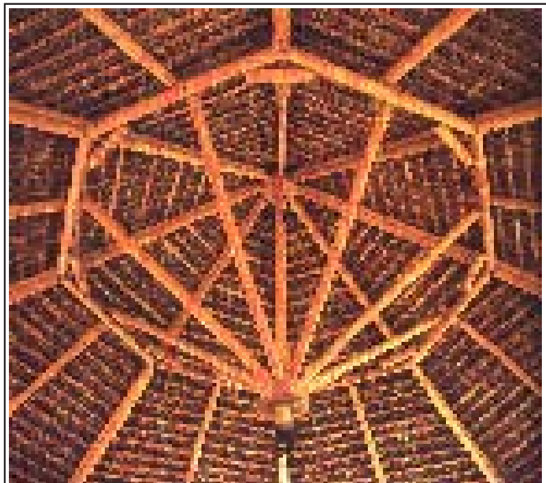
FIGURA 16 - COBERTURA COM BAMBU ROLIÇO FONTE: VILLEGAS (1989)
