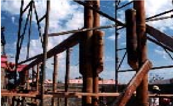
FIGURA 38 “FLAUTAS” DE SUSTENTAÇÃO DAS VIGAS (CONSOLE). FOTO: ARQ. RUBENS CARDOSO JR.
