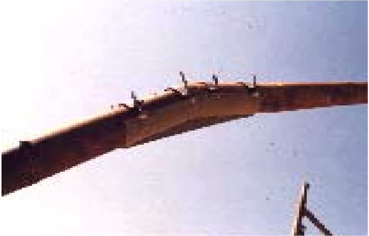
FIGURA 30 LUA DE UNIÃO E INCLINAÇÃO DA CALOTA. FOTO: ARQ. RUBENS CARDOSO JR.
