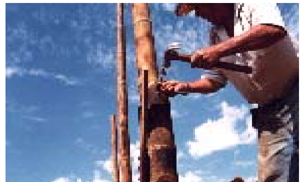
FIGURA 37 COLOCAÇÃO DOS PARAFUSOS. FOTO: ARQ. RUBENS CARDOSO JR.
