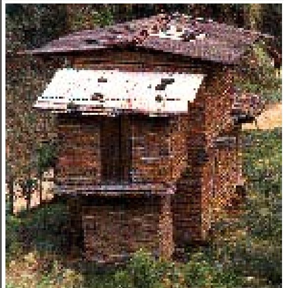
FIGURA 21 - CASA COM PAINÉIS DE TIRA DE BAMBU, REBOCADA COM BARRO. FONTE: ARQ. RUBENS CARDOSO JR. (ÍNDIA)
