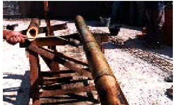
FIGURA 41 TRATAMENTO E SECAGEM A BASE DE CHAMA, UTILIZANDO-SE MAÇARICO À GAS. FOTO: ARQ. RUBENS CARDOSO JR.
